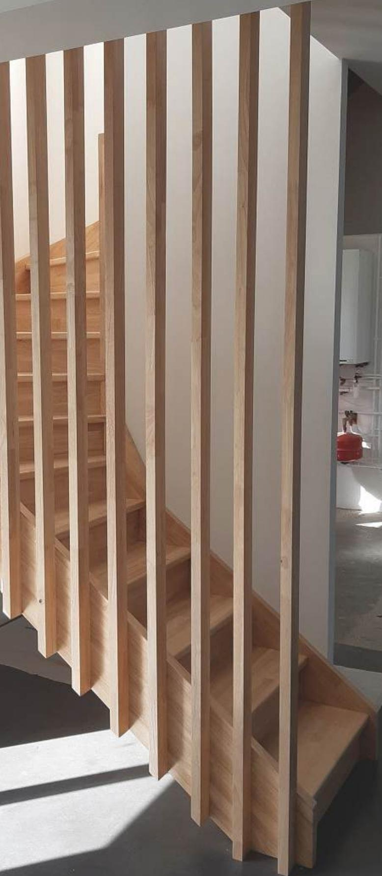
2/4 tournant hêtre. Garde-corps formant claustra jusque sous plafond à balustres. Fixation en applique sur le limon.
