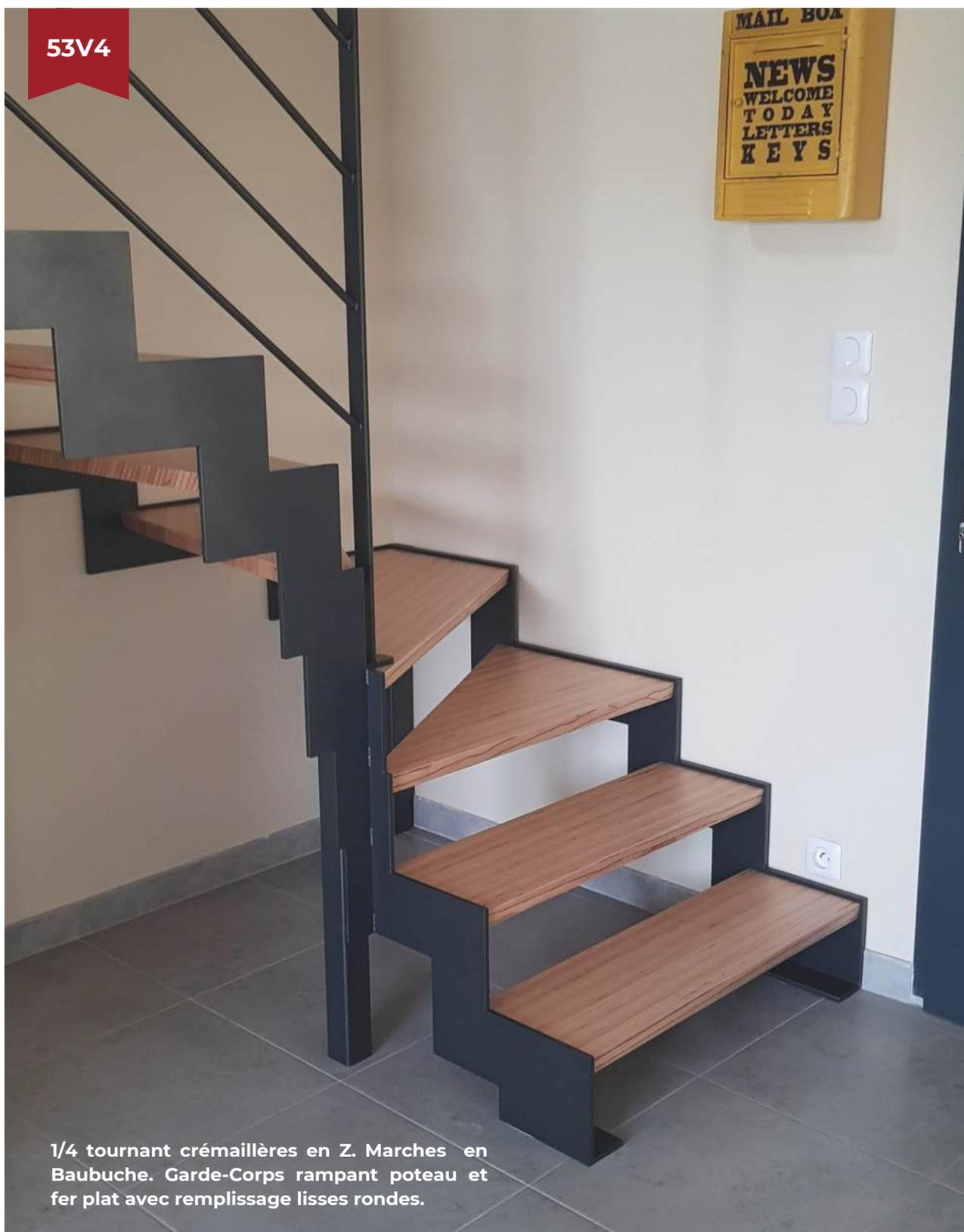
1/4 tournant crémaillères en Z. Marches en Baubuche. Garde-Corps rampant poteau et fer plat avec remplissage lisses rondes.
