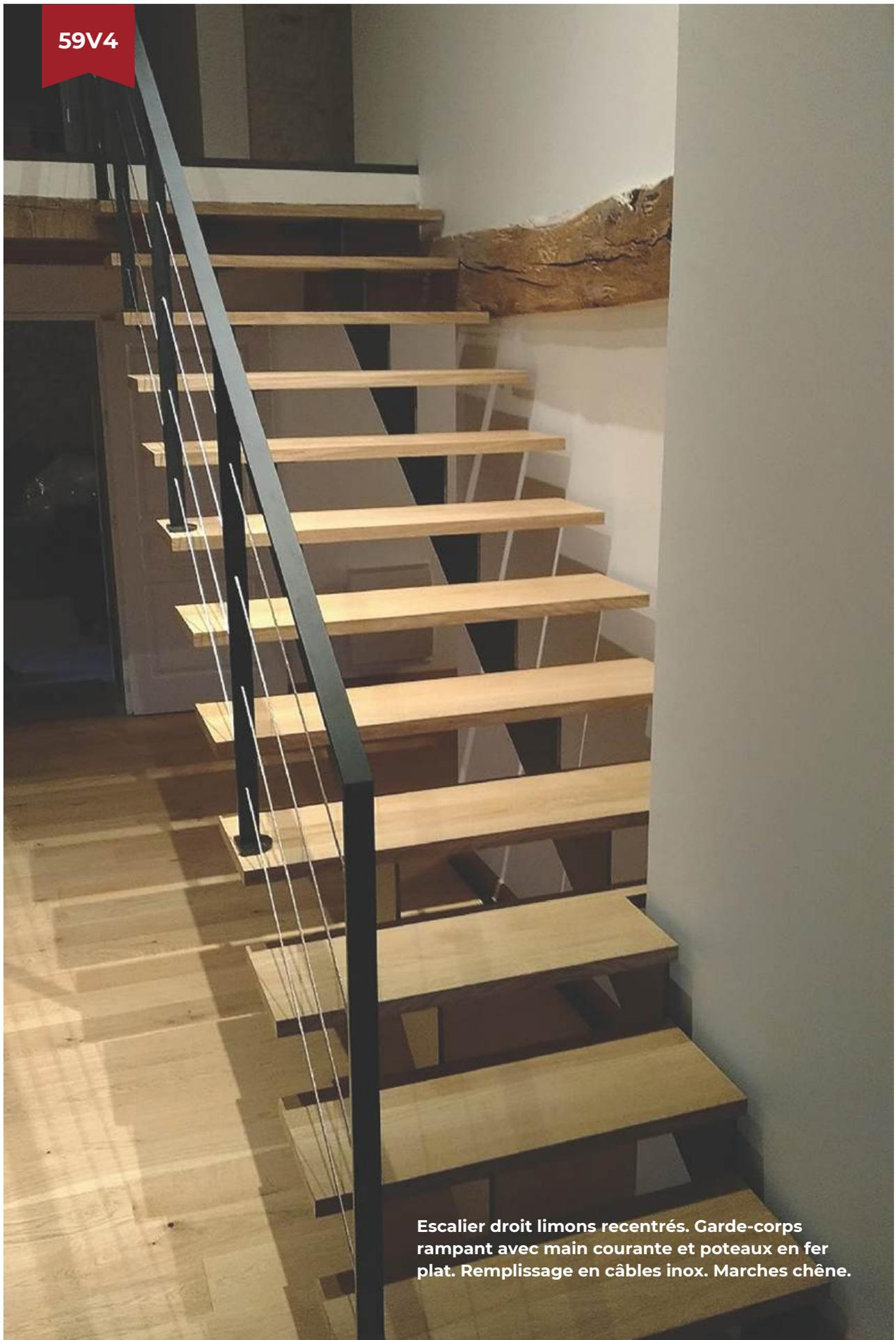
Escalier droit limons recentrés. Garde-corps rampant avec main courante et poteaux en fer plat. Remplissage en câbles inox. Marches chêne.
