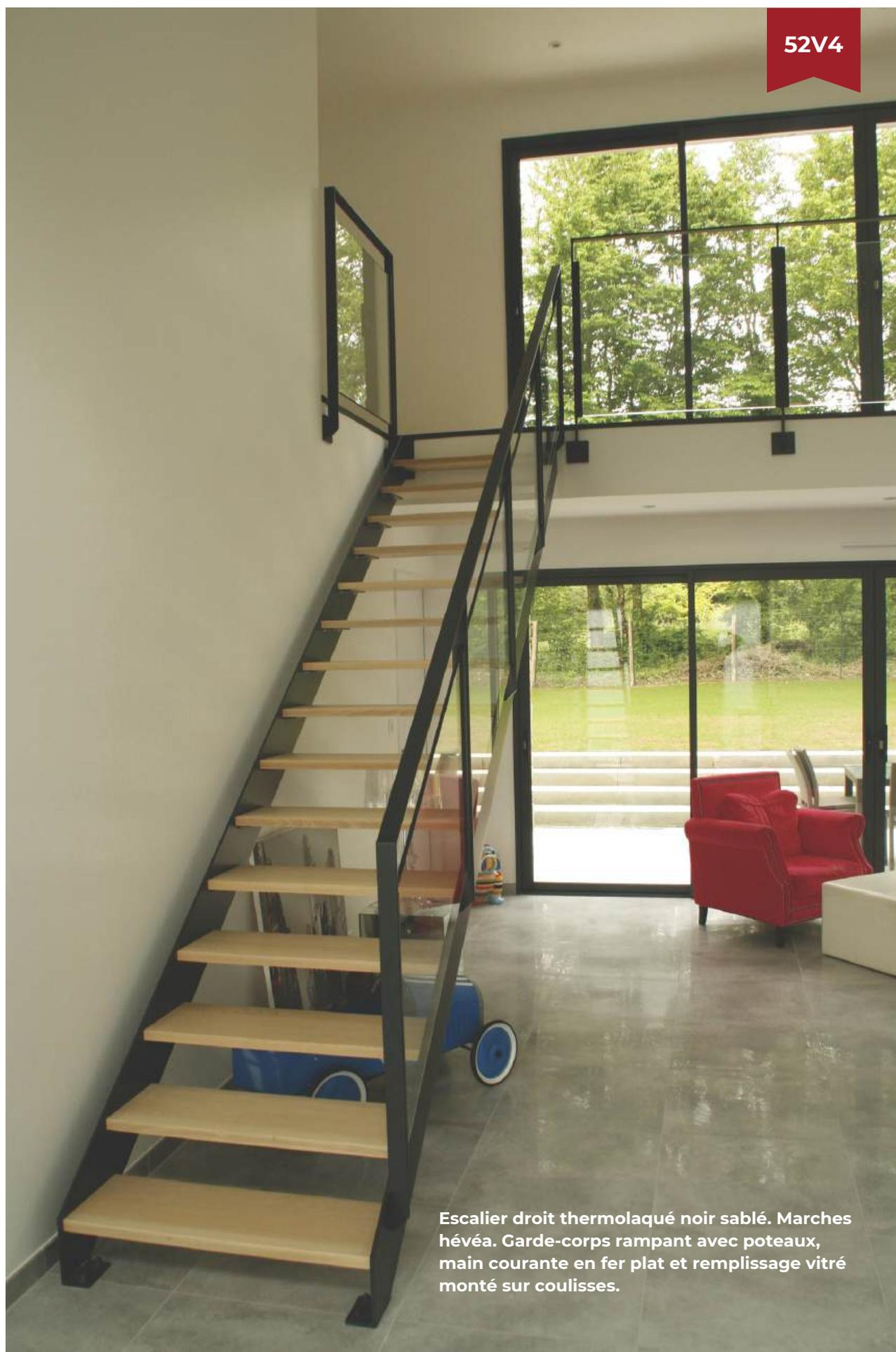
Escalier droit thermolaqué noir sablé. Marches hévéa. Garde-corps rampant avec poteaux, main courante en fer plat et remplissage vitré monté sur coulisses.
