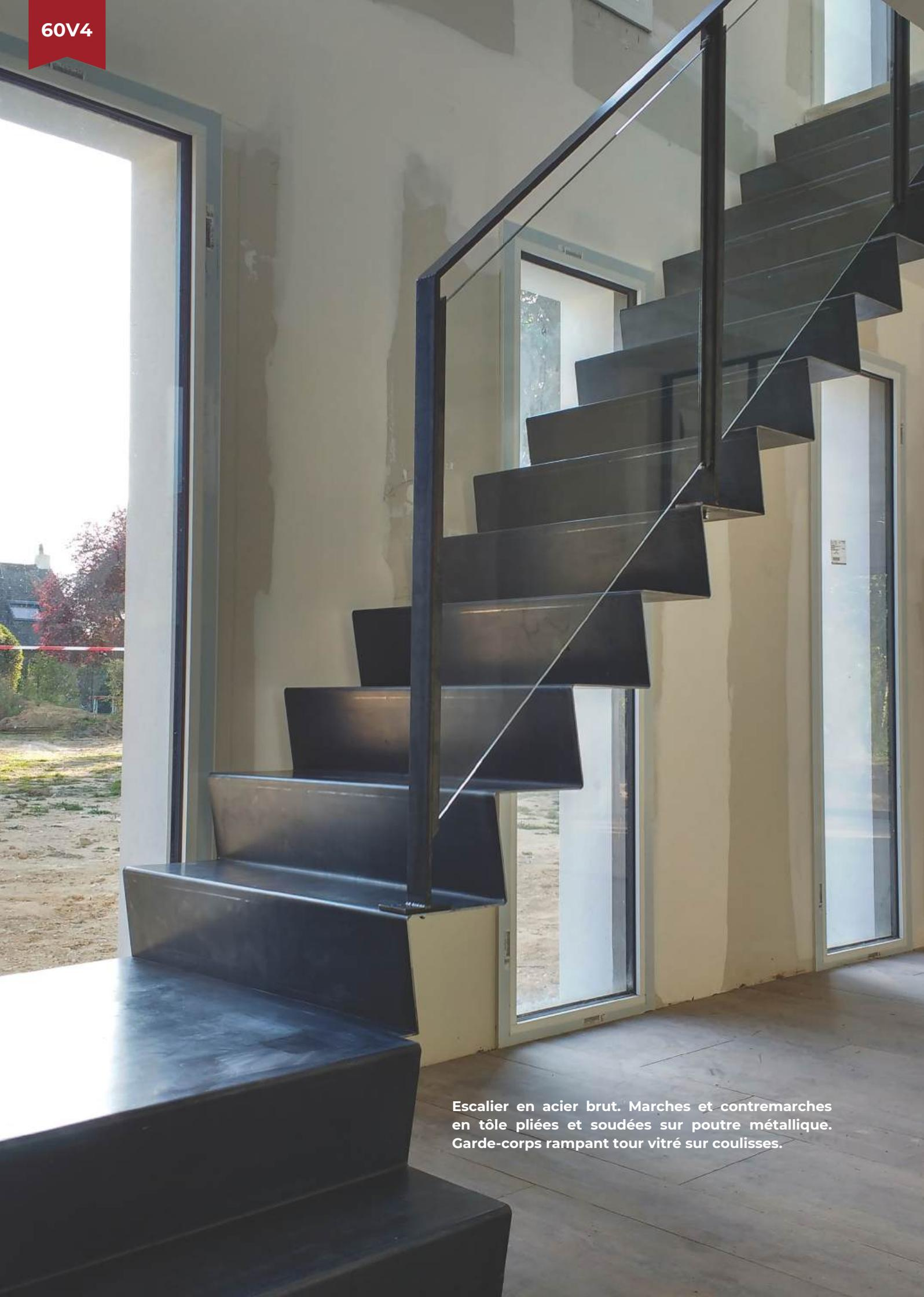
Escalier en acier brut. Marches et contremarches en tôle pliées et soudées sur poutre métallique. Garde-corps rampant tour vitré sur coulisses.
