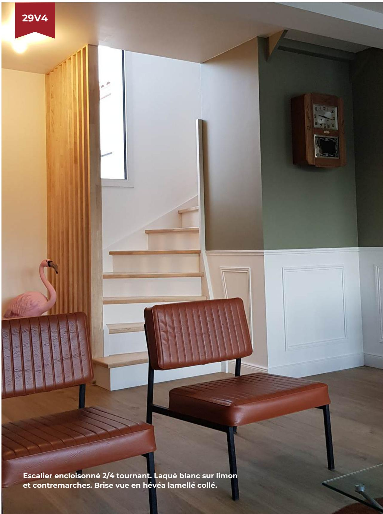
Escalier encloisonné 2/4 tournant. Laqué blanc sur limon et contremarches. Brise vue en hêtre lamellé collé.
